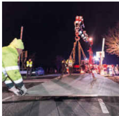
Stahlplatten verdecken die Gleise – der Bahnverkehr wird für eine Stunde unterbrochen
