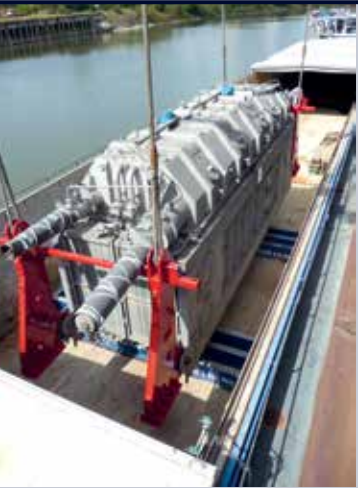
Umschlag des Transformators im Hafen Schönebeck auf die vorbereiteten Lastverteiler im Schubleichter LASTDRAGER 40 | Bild: Kahl
