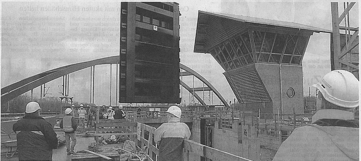
Ein schwerer Brocken am Haken: Die pro Stück rund 52 Tonnen schweren Flügel des neuen Schleusentores wurden mit zwei Kränen eingehoben.
