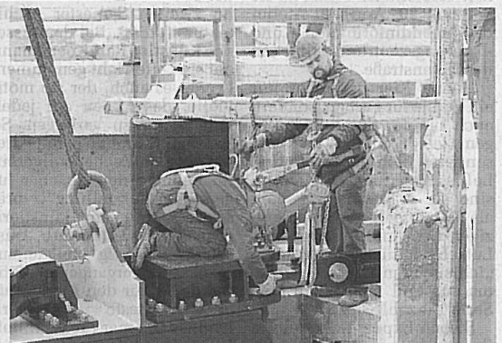
Millimeterarbeit war angesagt, damit die Sicherungsbolzen auch durch die vorgesehenen Löcher passten.
